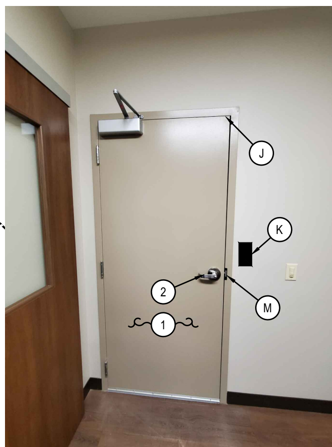
DOOR 118A - (INSIDE)
